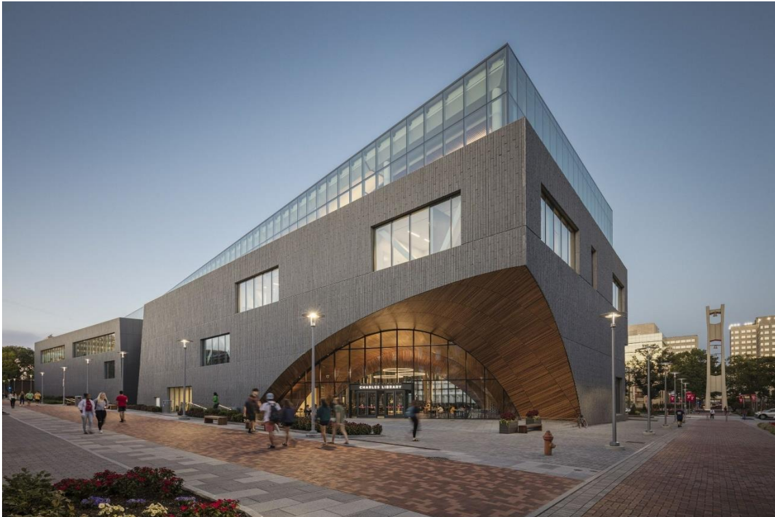
Figura 17: Fachada da Biblioteca Charles.
