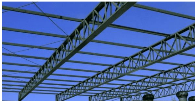
Figura 61 – Treliça metálica de cobertura
