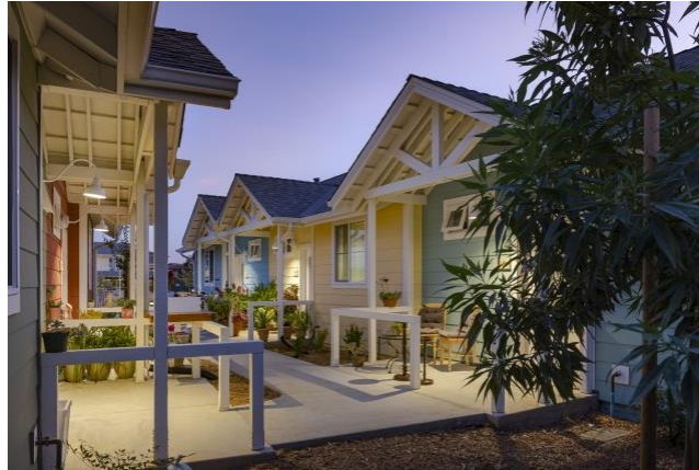
Figura 33 - Vista da circulação entre chalés da Valley View Senior Housing
