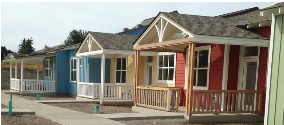
Figura 24 - Imagem da construção da Quimper Village Senior Cohousing
