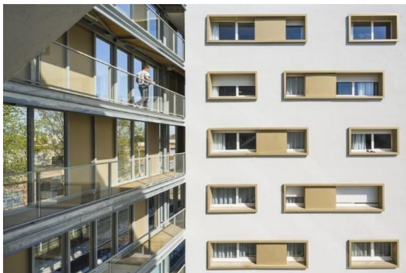
Figura 2: Fachada e circulações do edifício
