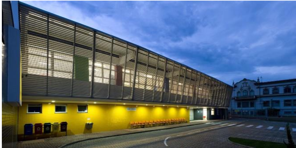
Figura 14 – Detalhes de brise na fachada
