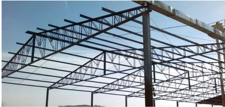
Figura 71 – Vigas e treliças metálicas
