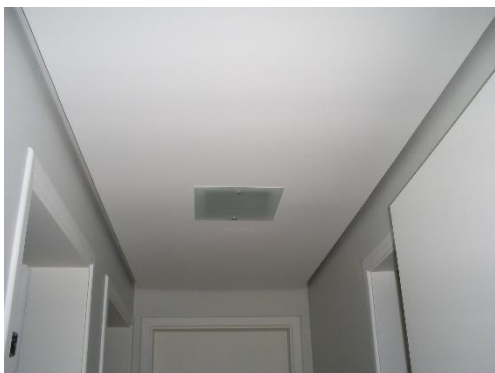
Figura 63: Forro em gesso tipo pé solto.
