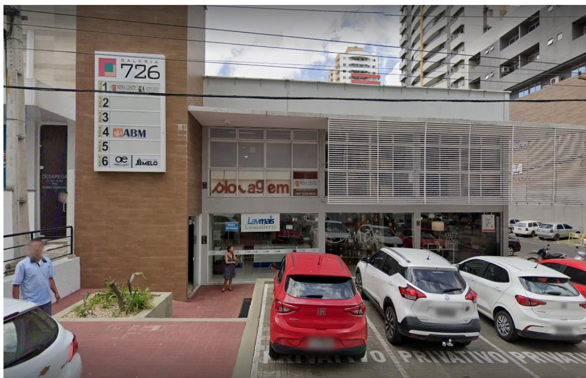
Figura 41: Fachada principal da Trapos e fiapos.
