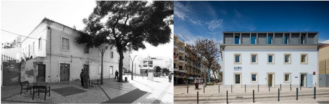
Figura 07 e 08 – Edificação Antes e Depois
